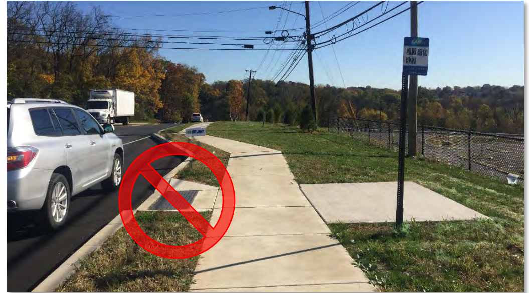
Not an ADA Curb Ramp
