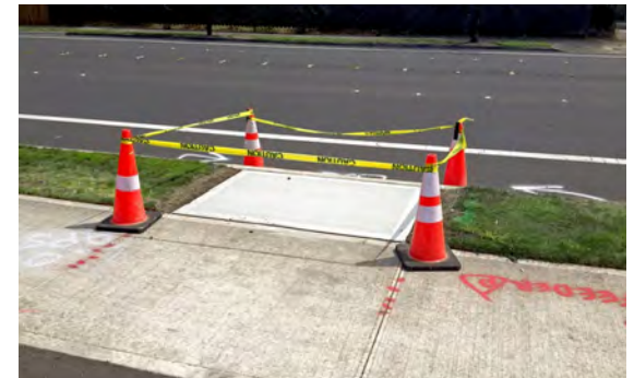
ADA loading pads
